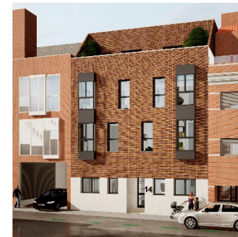
Fachada y cubierta
